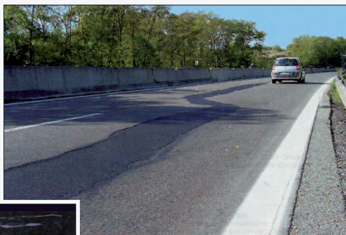
Figura 1 - Lungo la S.G.C. "Due Mari" (sul tratto Bettolle-Perugia), il Modipatch® è stato utilizzato per pareggiare lo smottamento dovuto a una frana del terreno per una lunghezza complessiva di oltre 50 m
