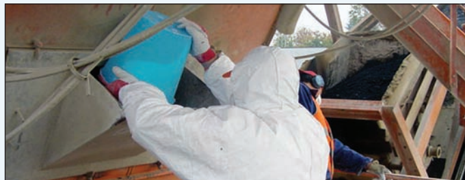
Il dosaggio manuale di Aspha-Min® all'interno del mescolatore
