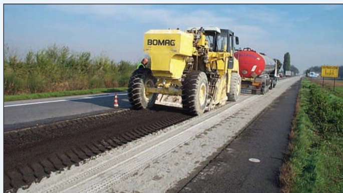
Una fase della rigenerazione a freddo dello strato di base
