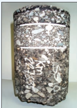
Il carotaggio dell'intero pacchetto bituminoso: sono evidenti i tre strati
