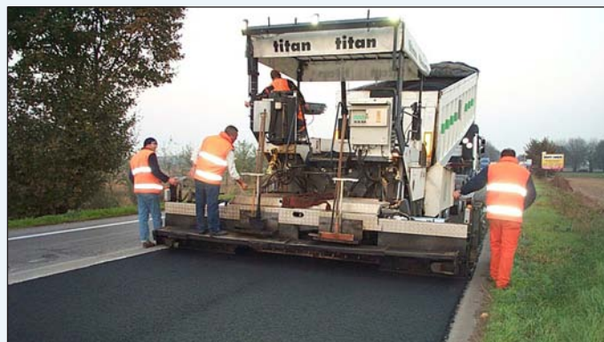
La posa in opera del manto d'usura anti-skid
